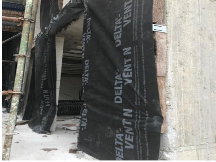
Resim3. Cephede su yalıtım örtüsü
