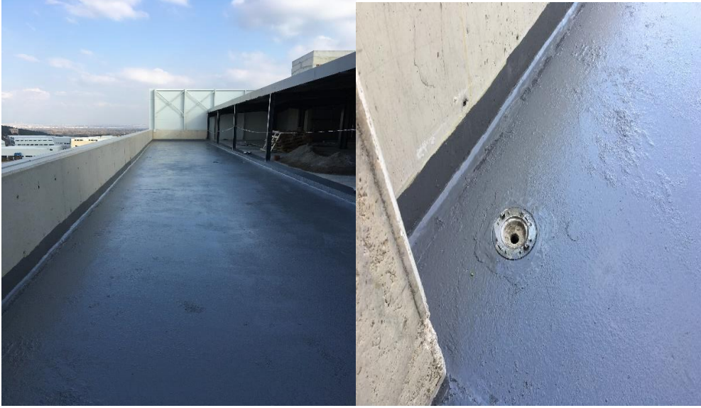
Resim 2. Poliüretan çatı yalıtımı
