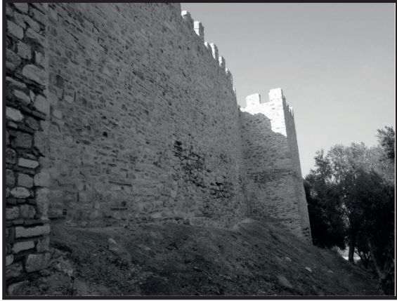
Resim 7b. Ayasuluk Kalesi 2013 Yılı Restorasyon çalışmalarını sonucu S11 numaralı sur duvarı ve K11 numaralı kule de orijinal kısımların tuğla şeritle ayrıldığı alanlar.
