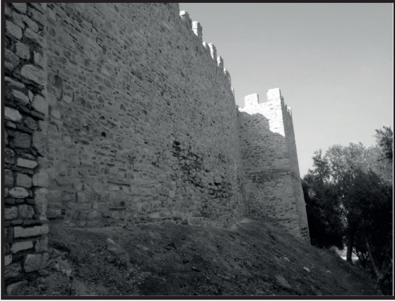
Resim 7b. Ayasuluk Kalesi 2013 Yılı Restorasyon çalışmalarını sonucu S11 numaralı sur duvarı ve K11 numaralı kule de orijinal kısımların tuğla şeritle ayrıldığı alanlar.
