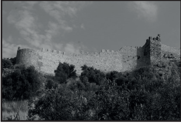
Resim 7a. Ayasuluk Kalesi 2013 Yılı Restorasyon çalışmaları S13 numaralı sur duvarı kuzeybatıdan görünümü.
