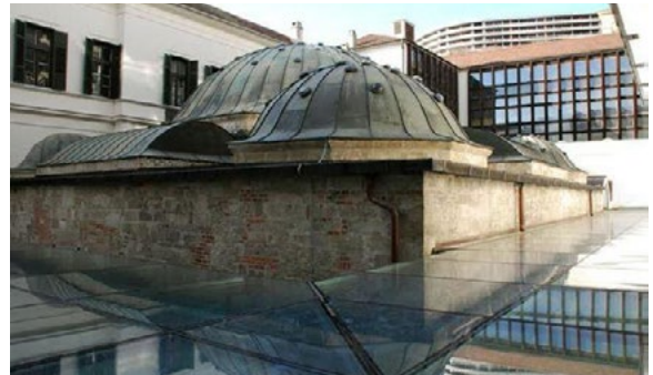
Resim 6. Veli Bey Hamamı Dış Görünüm
