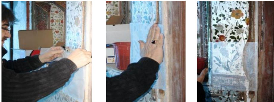
Resim 10. Duvar resminin güçlendirme aşaması
