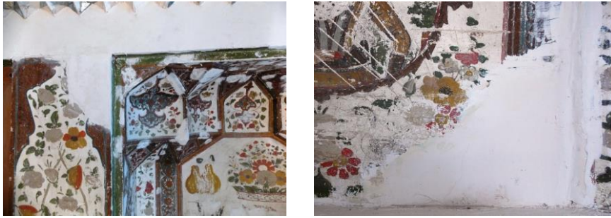
Resim 9. Sıva onarımı. Restorasyon aşaması
