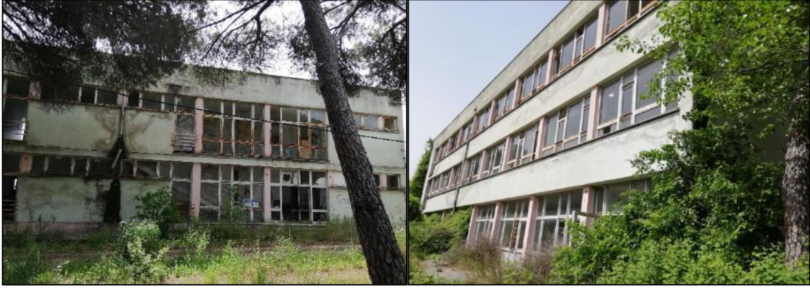
Şekil 4. Derslikler ön ve arka cephesinden görünüm
