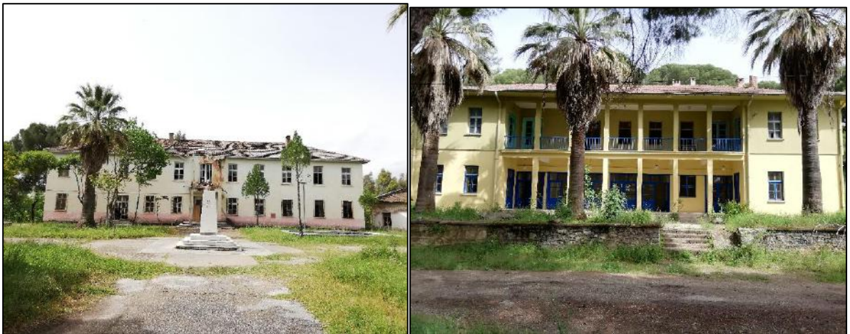
Şekil 9. İdari Bina-solda, Revir-sağda (ön cepheler)
