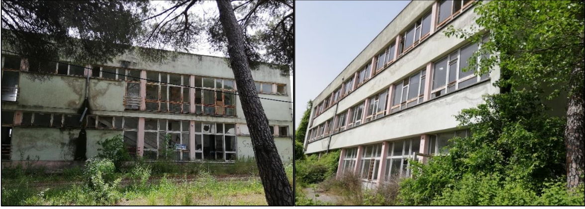
Şekil 4. Derslikler ön ve arka cephesinden görünüm
